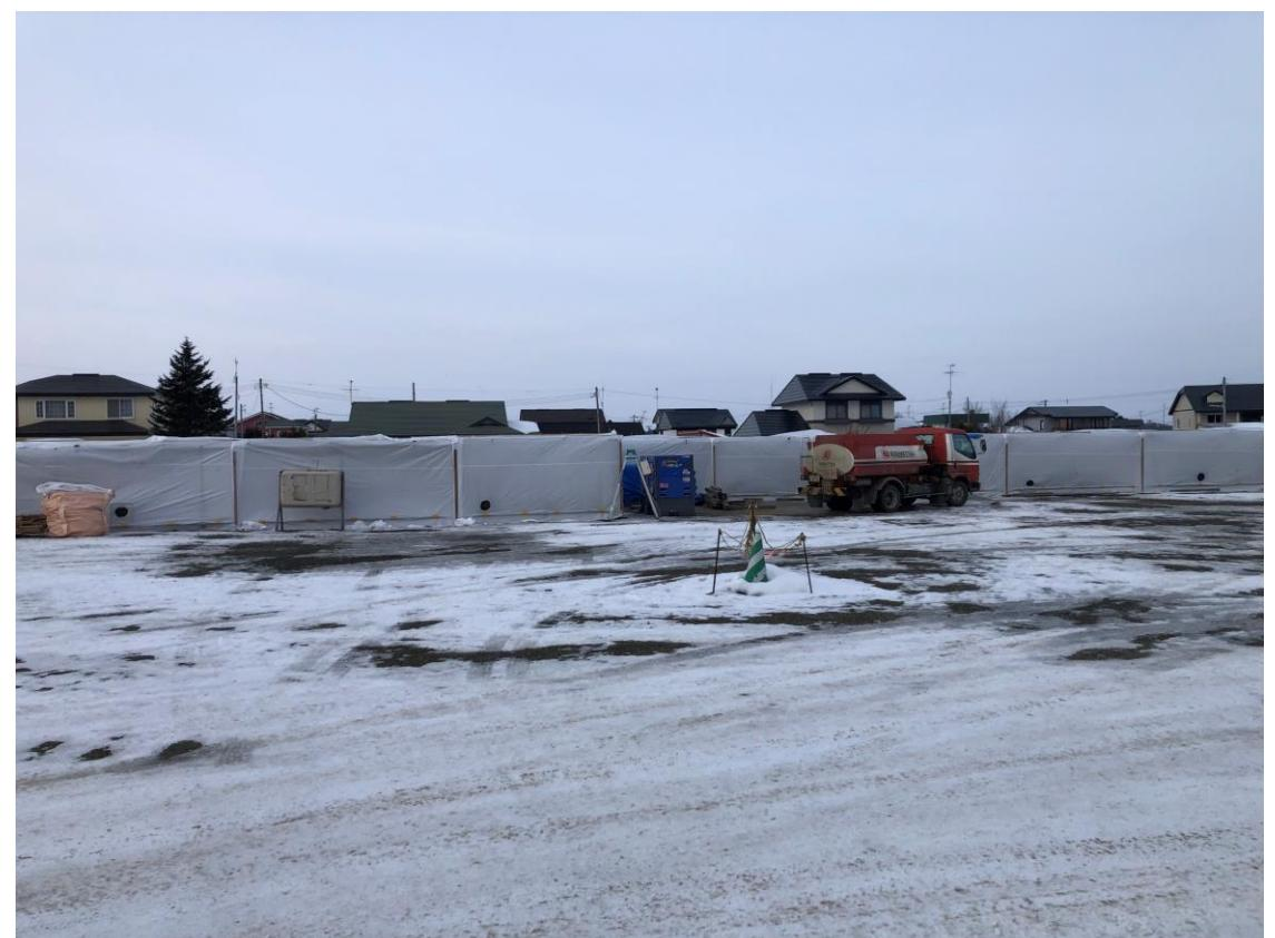
③【2月上旬】土間コンクリートが施工されました。そして、建て方工事のための足場が設置されます。
