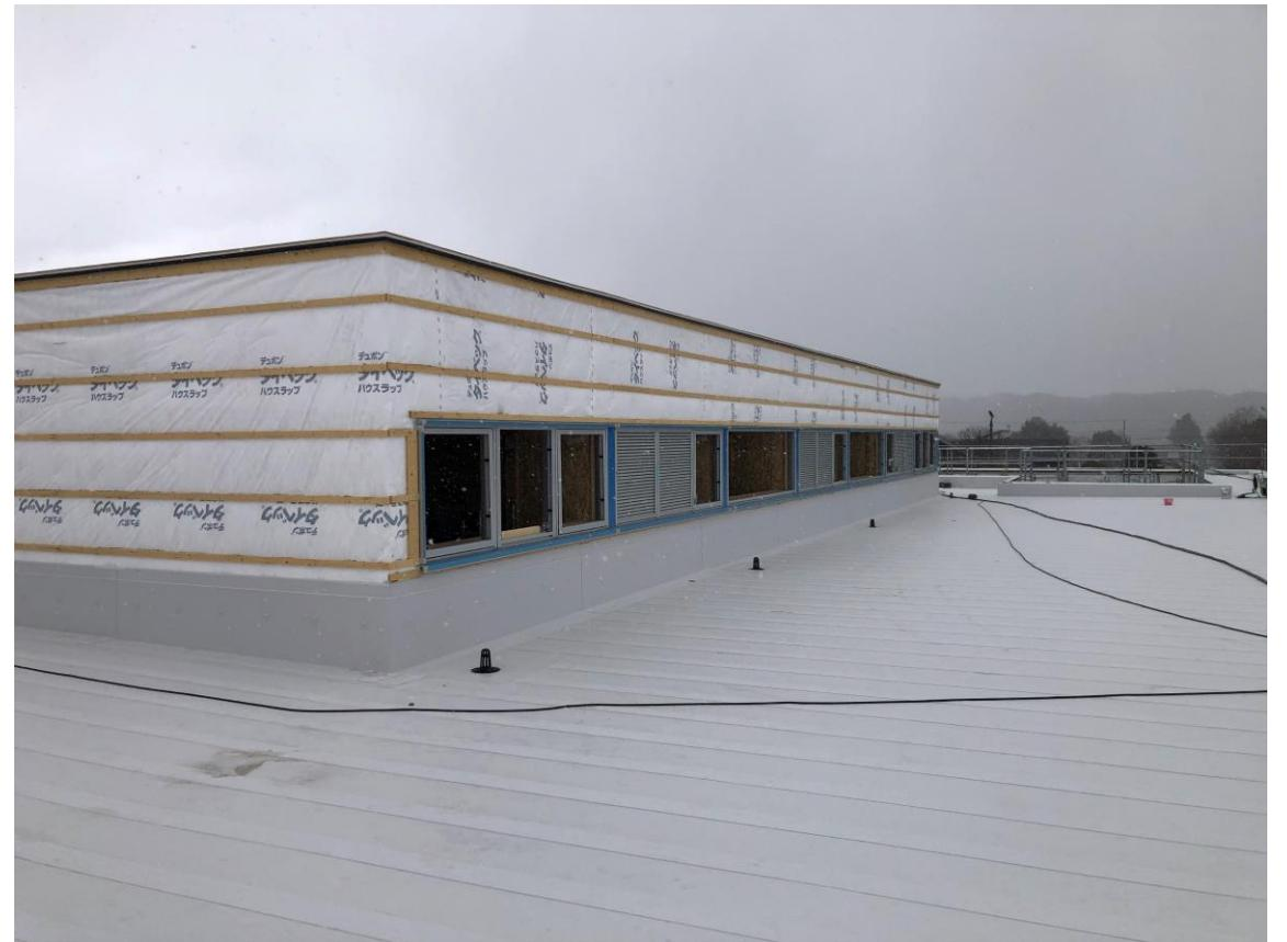
⑨玄関エントランスの同じ位置から。窓枠サッシや内壁下地が施工されました。窓枠の向こうは事務室です。
