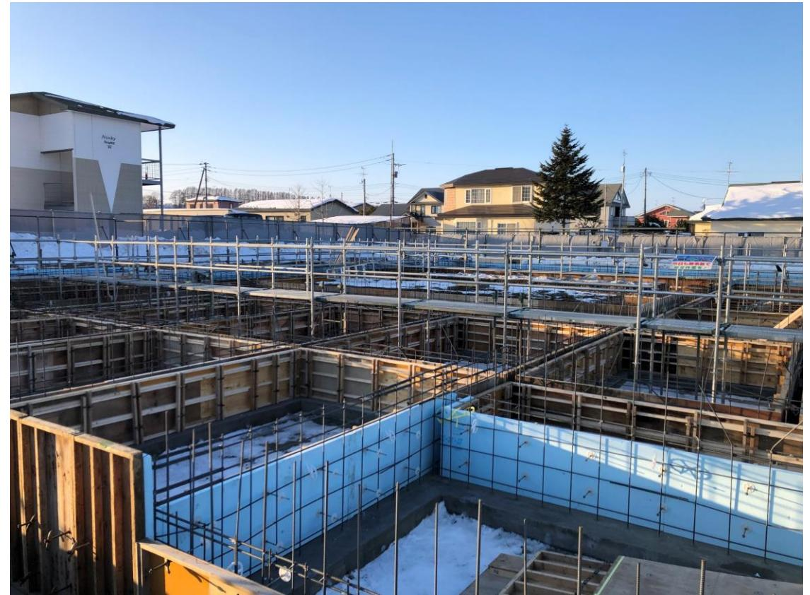
②【1月下旬】床部分に土間コンクリートを施工します。冬期間のため囲いをつくり作業が行われます。
