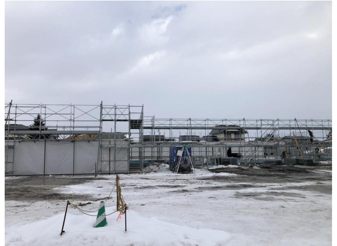
④【2月下旬】建て方工事が開始され、基礎部分の上に柱が組み立てられていきます。
