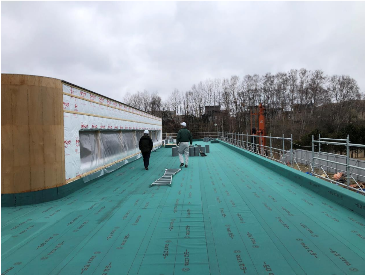
◇屋根の上の様子。白色の屋根材が施工されていきます。
