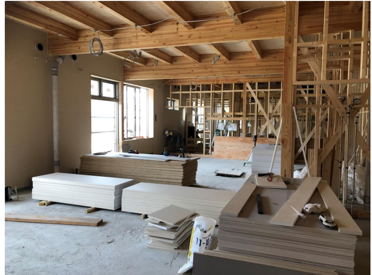
◇断熱材の上に内壁の下地が施工されます。
