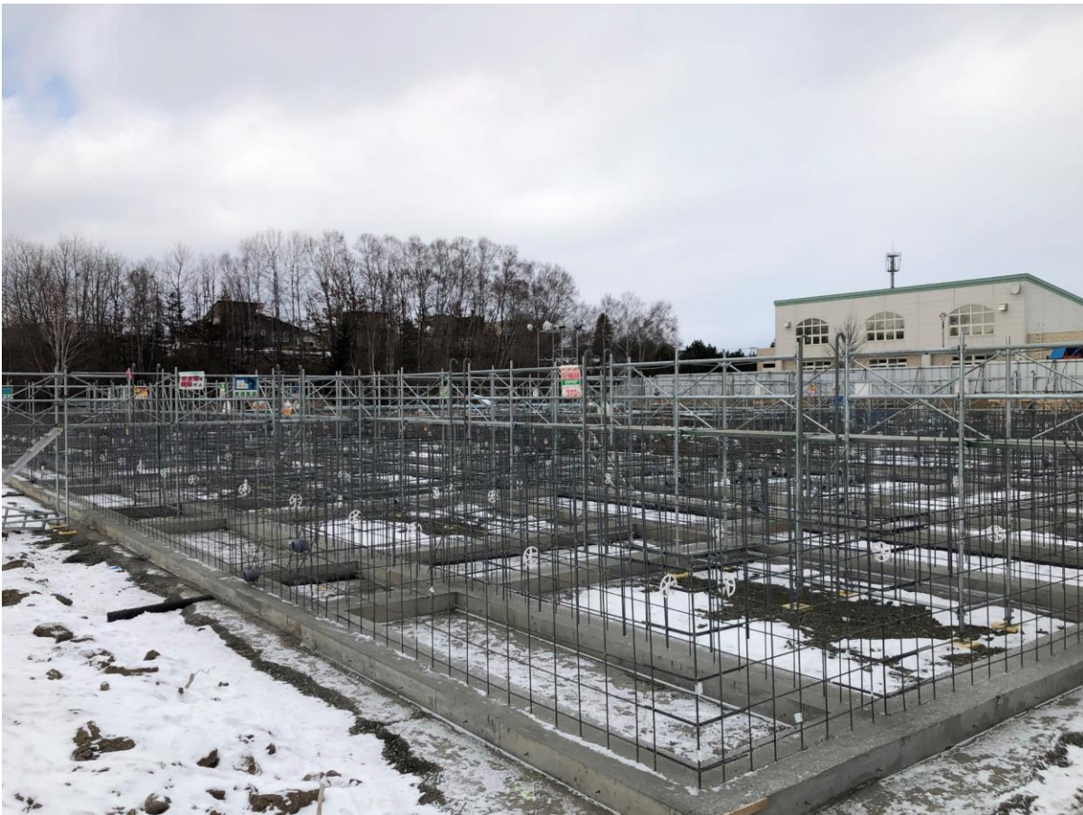
⑤真冬（1月）のため囲いの中をジェットヒーターで暖め、土間コンクリートを打設します。
