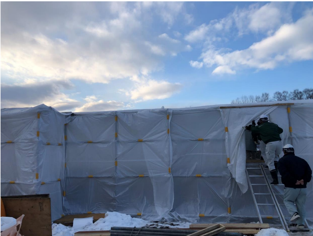
⑤真冬（1月）のため囲いの中をジェットヒーターで暖め、土間コンクリートを打設します。
