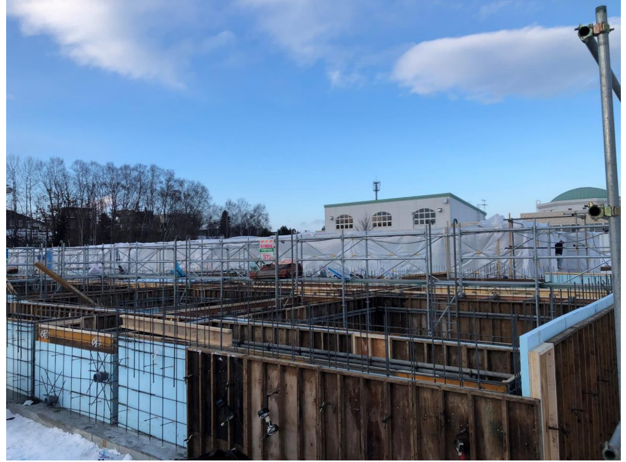
⑤真冬（1月）のため囲いの中をジェットヒーターで暖め、土間コンクリートを打設します。
