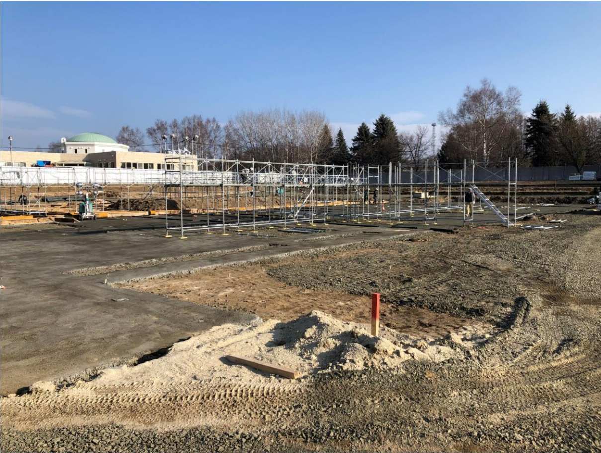
③基礎の型枠を取り付けます。各室の間取りとなります。
