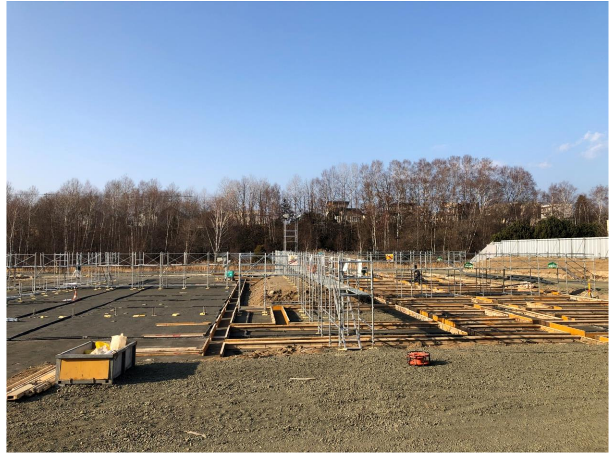
③基礎の型枠を取り付けます。各室の間取りとなります。
